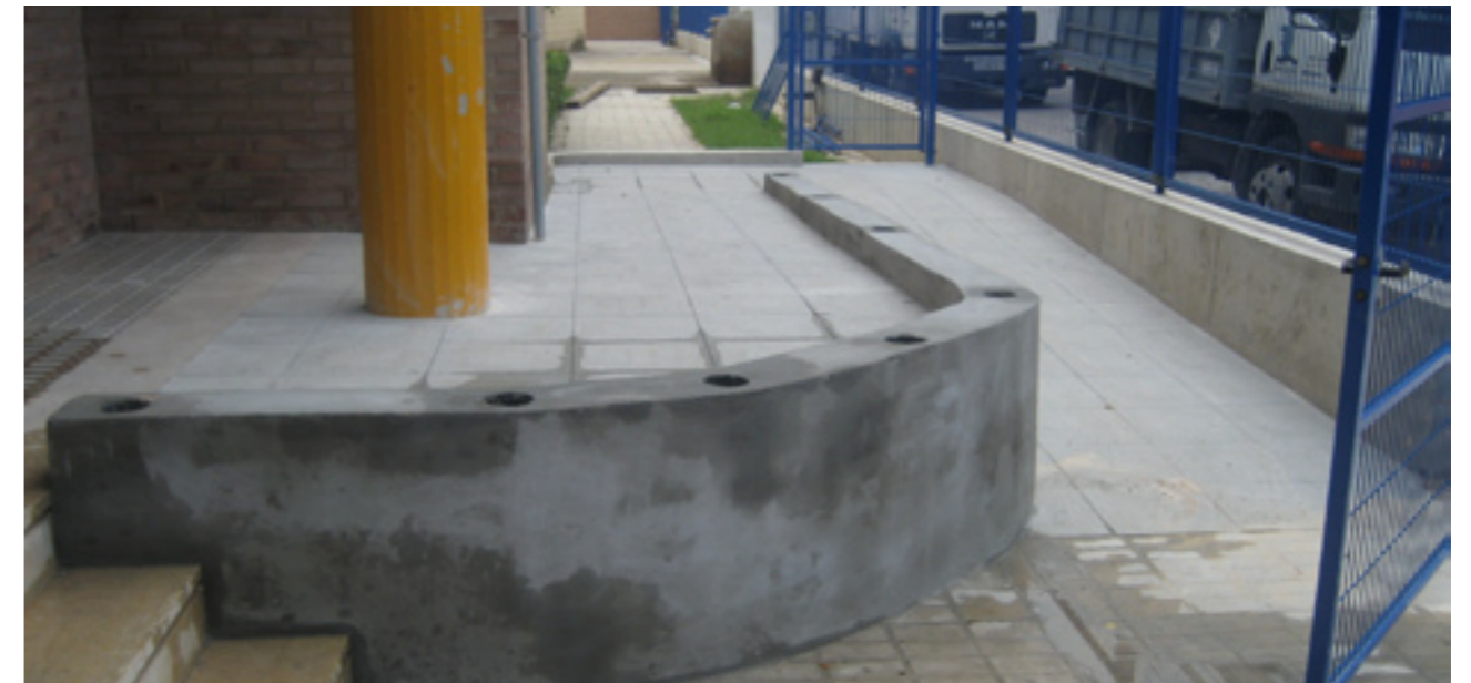
La rampa d'accés permetrà a les persones amb cadires de rodes accedir a l'entrada del Pavelló
