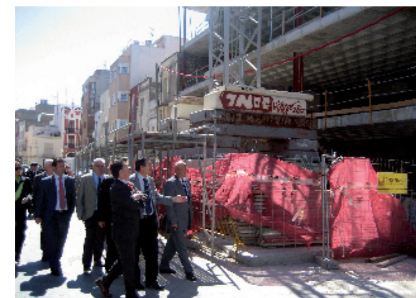
La comitiva es va desplaçar fins a les obres per comprovar la ubicació de l'edifici i la seua connexió amb els vials de comunicació de la ciutat.
